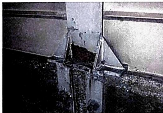
Figura 7 – Esempio di corrosione del montante.
