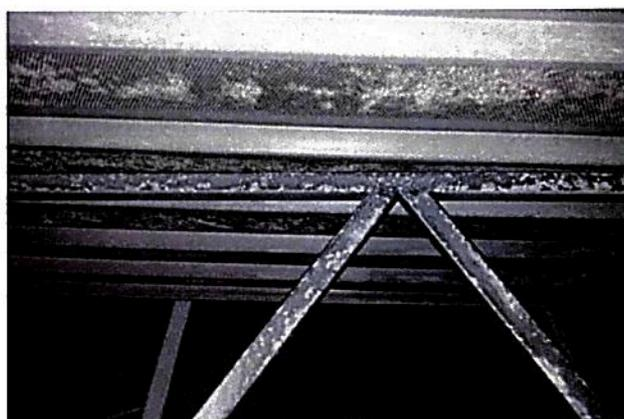
Figura 8 – Esempio di perdita dell'integrità dello strato di zinco a protezione della struttura metallica
